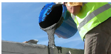
Hacer el vertido de forma rápida y continua.
