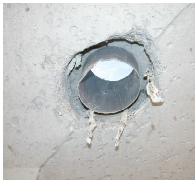
Rellenos entre PVC-hormigón.
