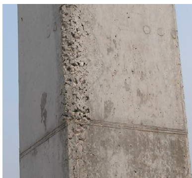
Reparación de pilares.
