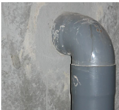
Rellenos entre PVC-hormigón.
