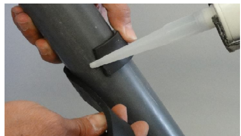
... y sujetarlo con una masilla de contacto
