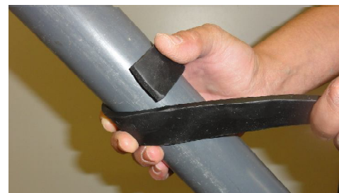
Colocar SELLAMAR alrededor del tubo de PVC ...
